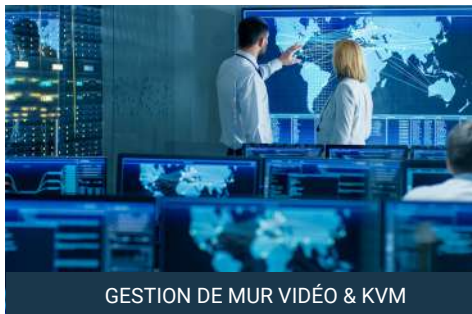
Salles de contrôle
